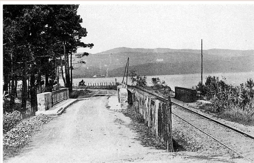
*L'ouvrage de la Castillanne a dû être allongé à 15 m après avoir été détruit par une crue en 1898*
